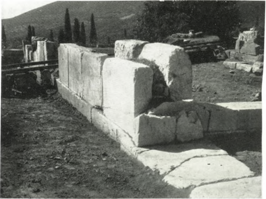
α. Όψις τῆς ἐξωτερικῆς παρειάς τοῦ διαμερίσματος Υ μετὰ τὴν ἀναστήλωσιν τῶν ὀρθοστατῶν.
