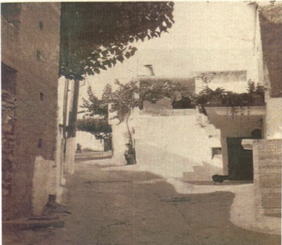
Γειτονιές στ' Ανώγεια μετά την ανοικοδόμηση
