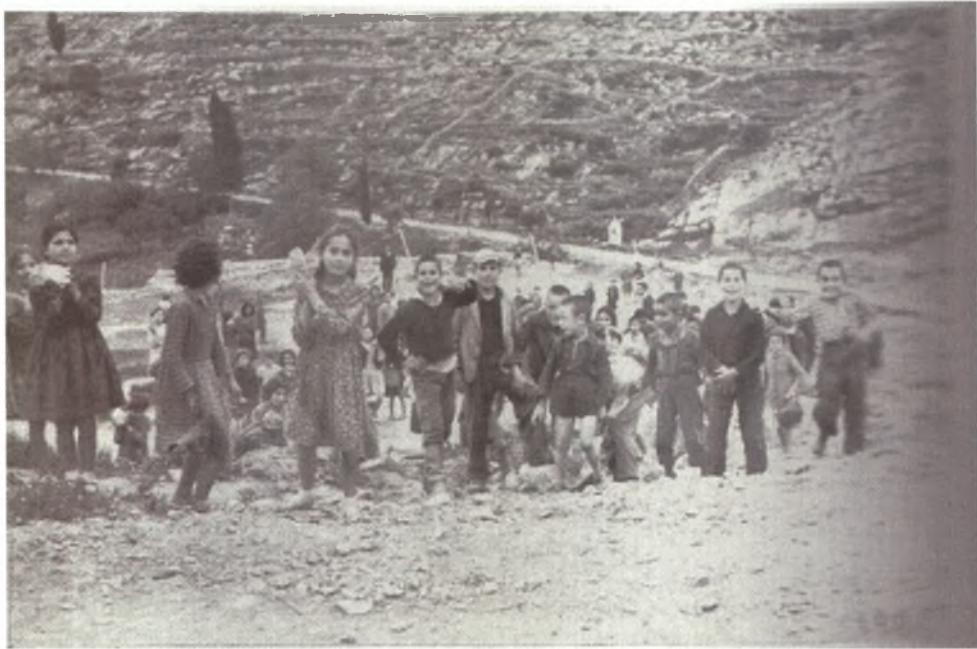
Οι μαθητές βοηθούν στην ισοπέδωση του χώρου του Β' Σχολείου
