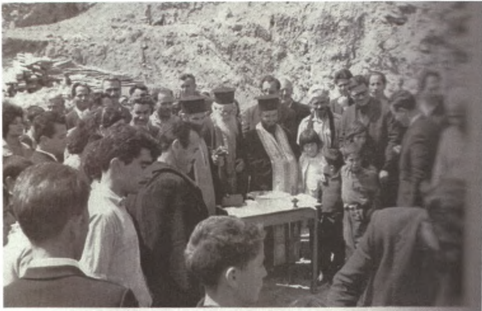
Θεμελίωση Β' Δημοτικού Σχολείου 1964
