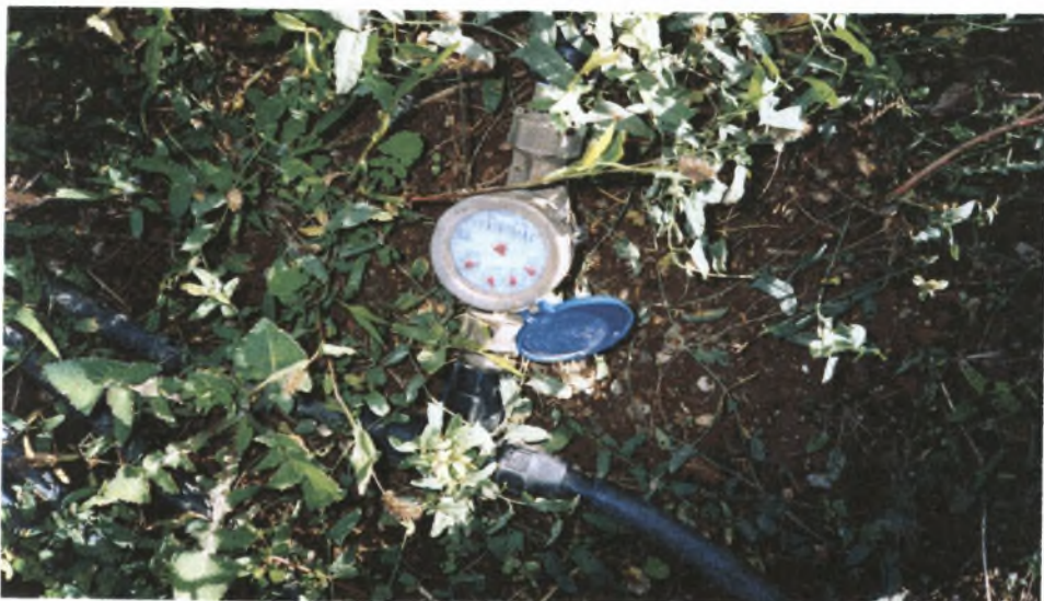
Εικόνα 5.7 Υδρόμετρο συστήματος άρδευσης
