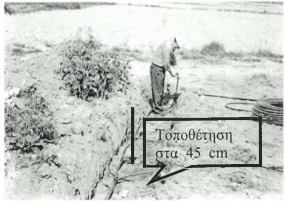
Εικ. 2 Τοποθέτηση υπόγειου αγωγού.
