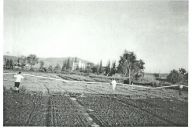
Εικ.8 Μεταφορά του αγωγού.
