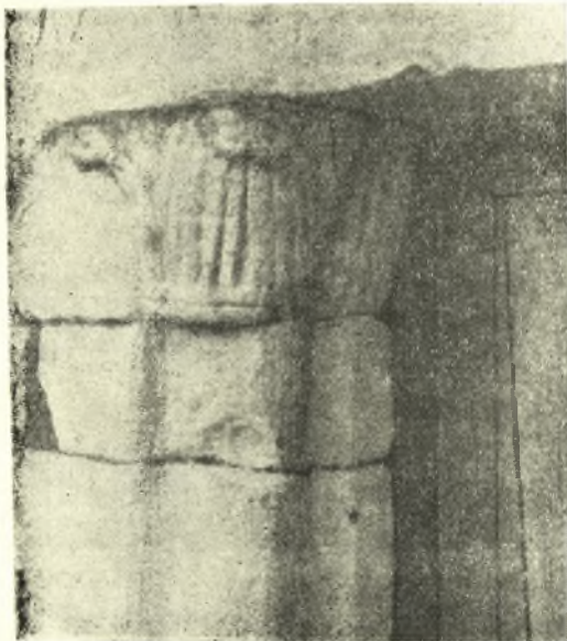
Εἰκ. 28. Παναγία «Ραχιώτισσα» Φλιούντος. Σταθμὸς τῆς δυτικῆς θύρας.
