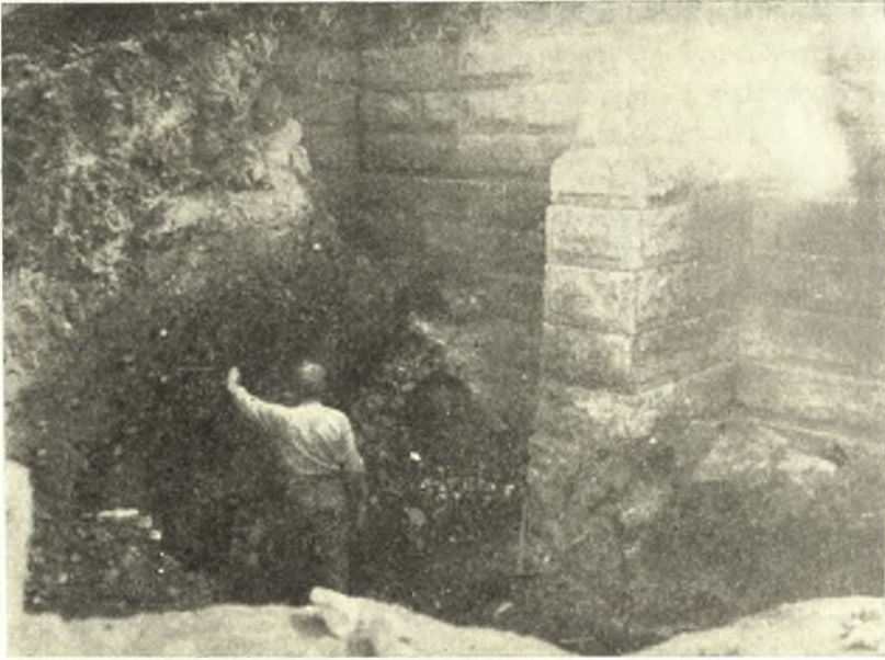
Εἰκ. 2. Ἡ βορειοδυτικὴ γωνία τοῦ ἀναλήμματος μετὰ τῶν ἀντηριδῶν.
