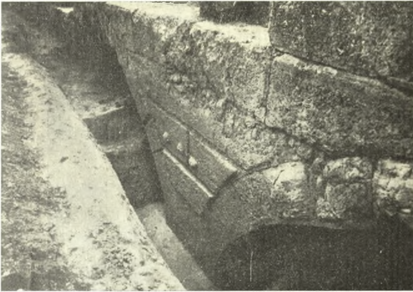
Εἰκ. 3. Βάθρον τῆς γεφύρας πρὸς τὰ κατάντη τοῦ ρεύματος.
