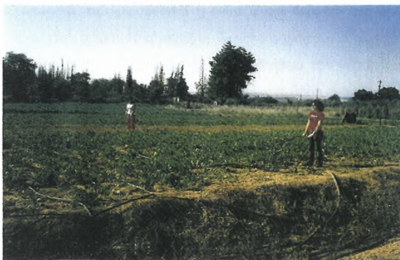
Εικόνα 3.8 Εγκατάσταση επιφανειακού δικτύου άρδευσης.
