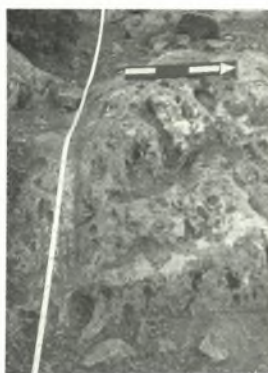
Εικ. 2β. Άμαξιτὸς ὁδὸς στὴ θέση Πουραγκέλι· λεπτομέρεια
