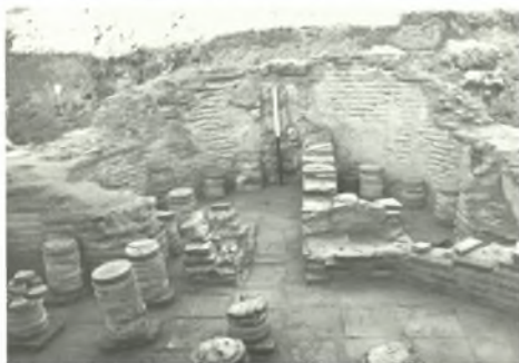
Εικ. 6. Άργος, οικόπεδο Α. Πακουμάκη: τμήμα υποκαύστων κάτω από τον ημικυκλικό λουτήρα της κεντρικής αίθουσας
