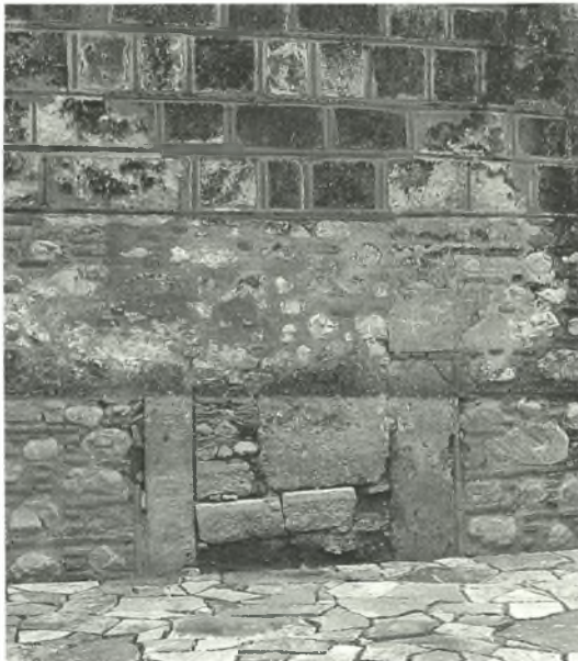
Εικ. 6. Η βόρεια θύρα μετά το πέρας της ανασκαφικής διερεύνησης
