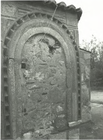
Εικ. 4. Το παράθυρο της αφίδας του Ιερού. Διακρίνεται καθαρά ο μεσαίος πώρινος λοβός του τρίλοβου παραθύρου
