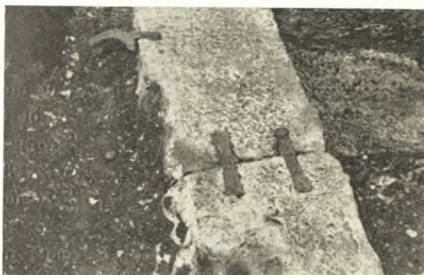
Εἰκ. 23. Τμήμα τῆς ἀνατολικῆς πλευρᾶς τοῦ ναΐσκου.
