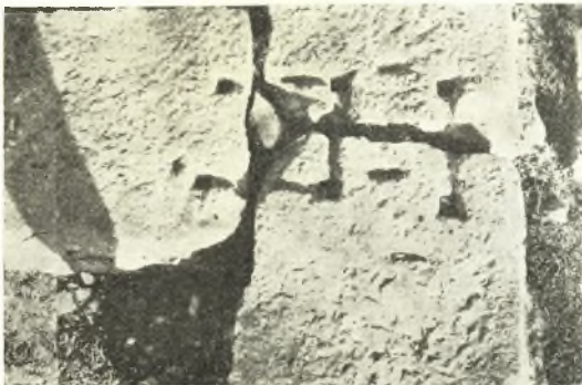
Εἰκ. 30. Τὸ ἀν. τμήμα τοῦ σηκοπρονάου τοίχου εἰς τὸ σημεῖον συνδέσεως μετὰ τῆς ἀν. μακρᾶς πλευρᾶς τοῦ ναῖσκου.
