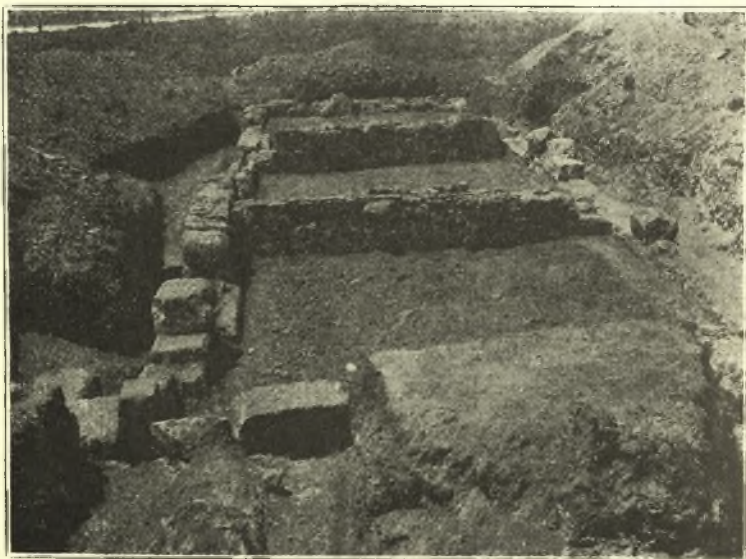
Εἰκ. 5. Οἰκοδόμημα Β ἀπ' Ἀνατολῶν.
