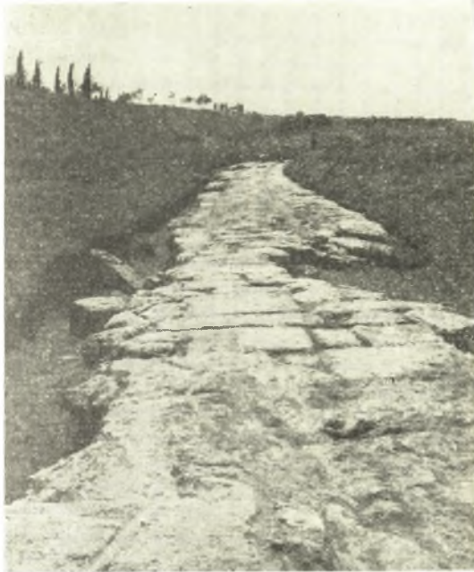
Εἰκ. 3. Τὸ ἄνευ ἀυλακώσεων τμήμα τοῦ διόλκου, ἐπὶ τοῦ ὁποίου ἐξετείνοντο τὰ πρόσθετα ἐπὶ τοῦ πλακοστρώτου θεμέλια.
