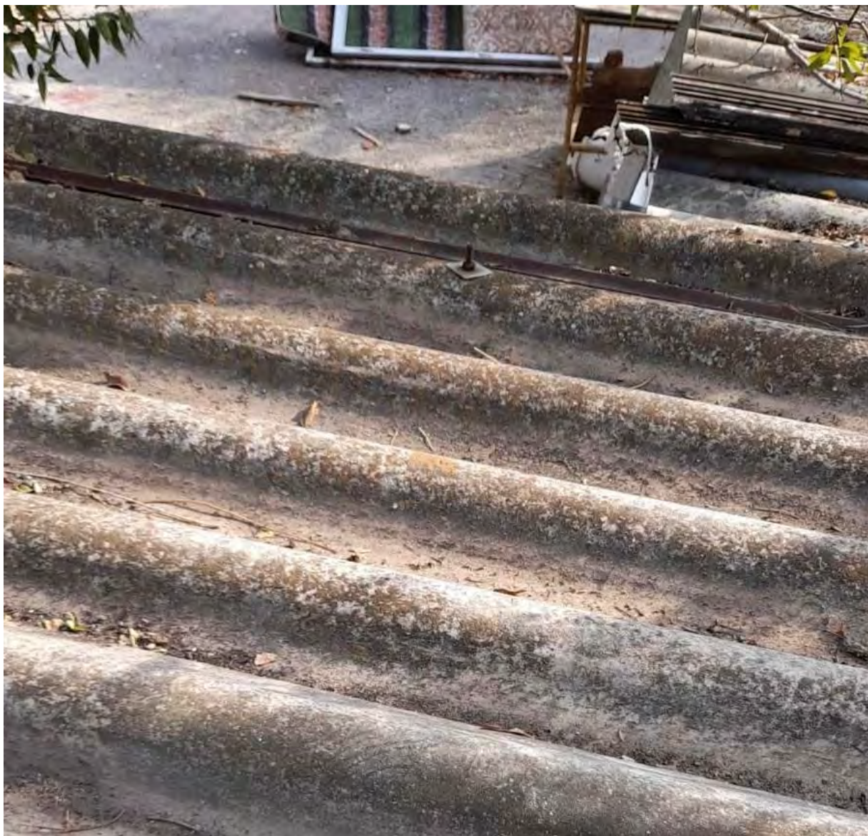
Εικόνα 3.2.: Στέγη αμιαντοτσιμέντου. Πηγή: Συλλογή συγγραφέως, 2024
