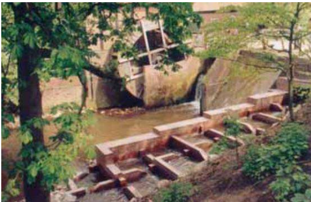
Εικόνα 7: Κατασκευή κλίμακας Pool weir στην Βέρνη (Ελβετία) (FAO, 2002)
