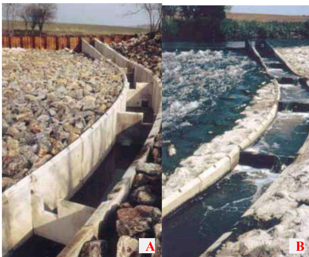
Εικόνα 8: Κατασκευή κλίμακας Pool weir χωρίς παροχή ροής (Α) και με παροχή ροής (Β) (FAO, 2002)
