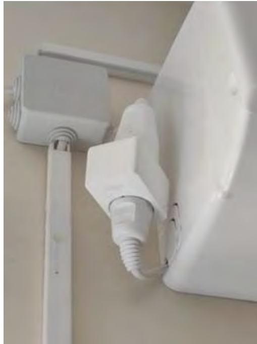
Εικόνα 24: Εγκατάσταση έξυπνης πρίζας
