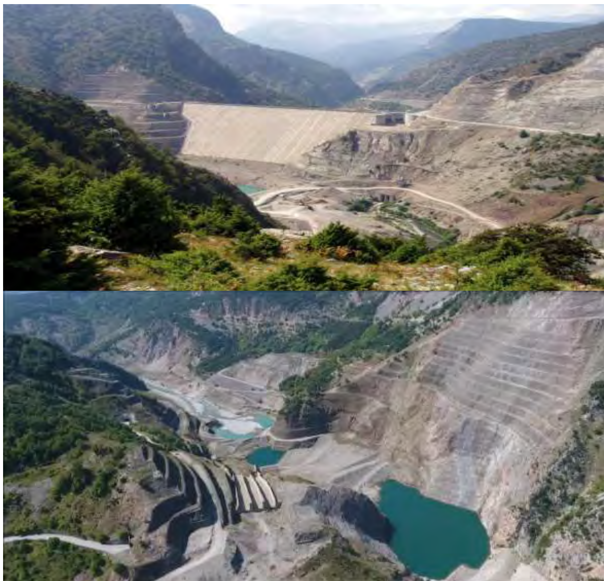
Εικόνες 128-129: Πάνω: Φράγμα Μεσοχώρας. Το φράγμα Μεσοχώρας απλά θα υπάρχει ακόμη μία βαθμίδα εκμετάλλευσης της υδραυλικής ενέργειας του ποταμού, δεν είναι έργο της εκτροπής του Αχελώου (όπως το διαφήμιζε η ΔΕΗ). Η εκτροπή θα γίνει (αν γίνει) χαμηλότερα στο φράγμα Συκιάς. Εδώ Κάτω: Φράγμα Συκιάς. Η εκτροπή του Αχελώου θα γίνει στο φράγμα Συκιάς. (Πηγή: (wikimapia.org))
