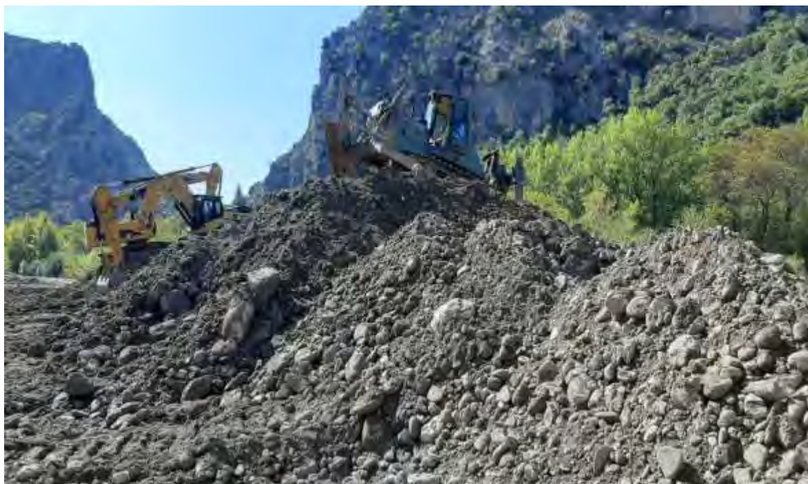
Εικόνα 90: Διευθέτηση για αύξηση της παροχτευτικότητας του Ρέματος Παμισσού και ανασχετικού έργου για την προστασία του Μουζακίου Τρικάλων μετά από μεταφορά φερτών υλικών, κατά τον Μεσογειακό κυκλώνα ΙΑΝΟΣ. (Θεσσαλία) (Πηγή: Προσωπικό Αρχείο)
