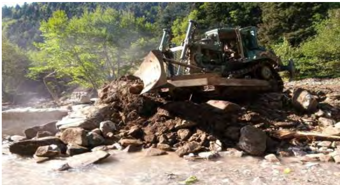
Εικόνα 85: Διευθέτηση του Ρέματος Καριτσιώτη στη Λίμνη Πλαστήρα μετά από μεταφορά φερτών υλικών , κατά τον Μεσογειακό κυκλώνα ΙΑΝΟΣ. (Θεσσαλία) (Πηγή: Προσωπικό Αρχείο)
