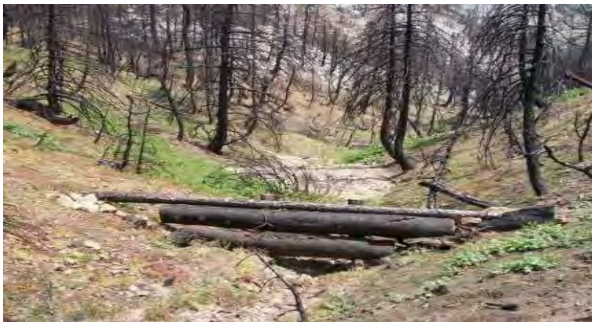
Εικόνα 70: Αποτυχημένη προσπάθεια αντιδιαβρωτικού έργου για συγκράτηση φερτών [(φωτ) Μ. Παπαθεοδοσίου, και Δ. Χριστοδούλου(2009)]
