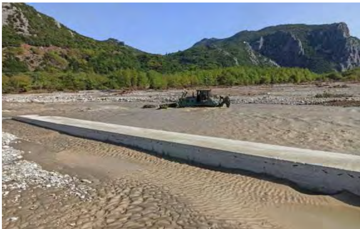
Εικόνα 16 : Εργασίες διευθέτησης του Παμισσού ποταμού πλησίον του Μουζακίου Καρδίτσας από τις πλημμύρες που προκάλεσε ο τροπικός τροπικό Κυκλώνα Ιανό τον Σεπ 2020. Εργασίες που ξεκίνησαν άμεσα (3 ημέρες) μετά την έλευση της πλημμύρας (Πηγή: Προσωπικό Αρχείο)
