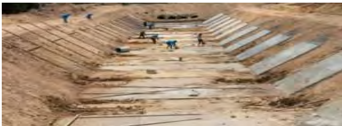
Εικόνα 93: Κατασκευή αποστραγγιστικών συνδετήριων αγωγών με τον ποταμό Κηφισό που λειτουργεί ως αποστραγγιστικό για το Λεκανοπέδιο Αττικής. (Πηγή: Διαδίκτυο )
