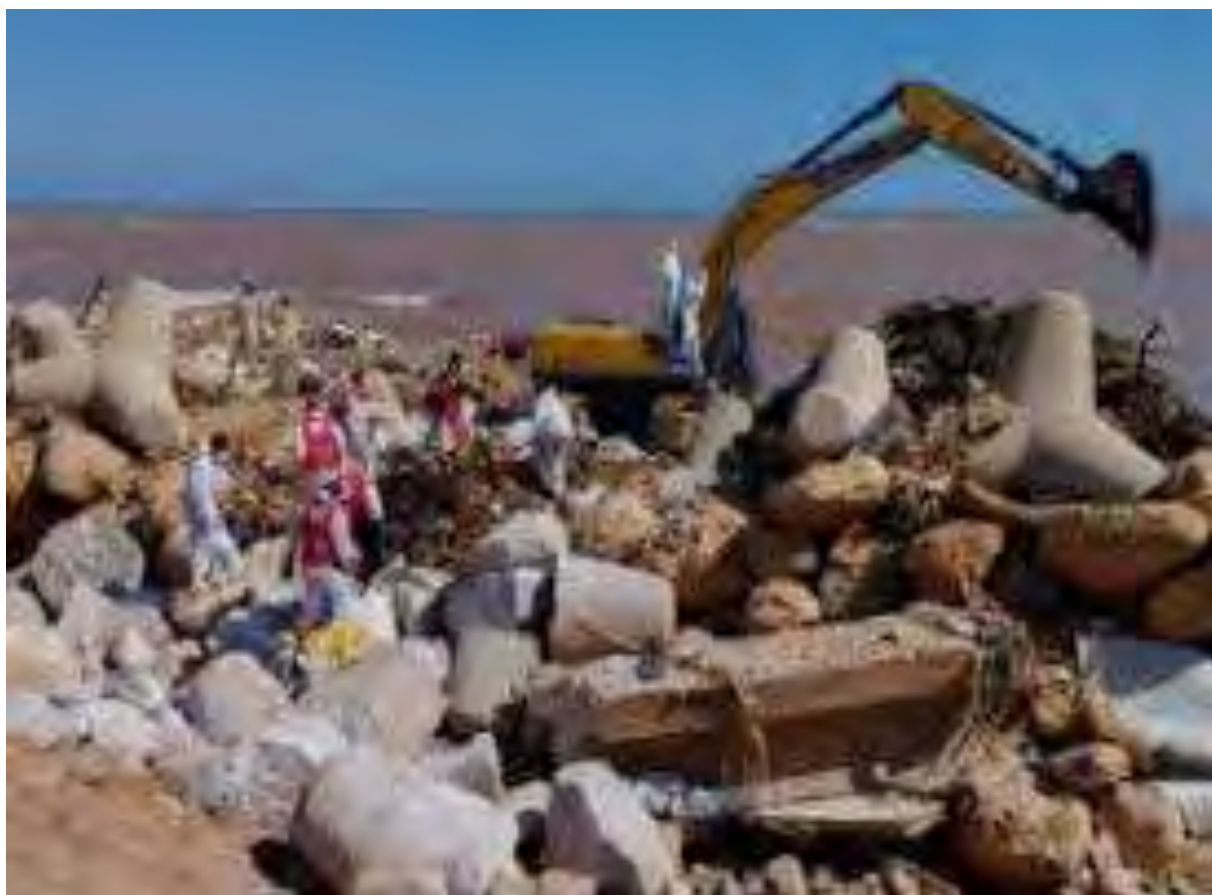
Εικόνα 9: Αποκατάσταση προστατευτικού και αντιδιαβρωτικού έργου κρηπιδώματος στο παραθαλάσσιο χωριό Αγ. Ιωάννης Πηλίου κατόπιν του πλημμυρικού φαινομένου Ντάνιελ) (Πηγή: Διαδίκτυο)
