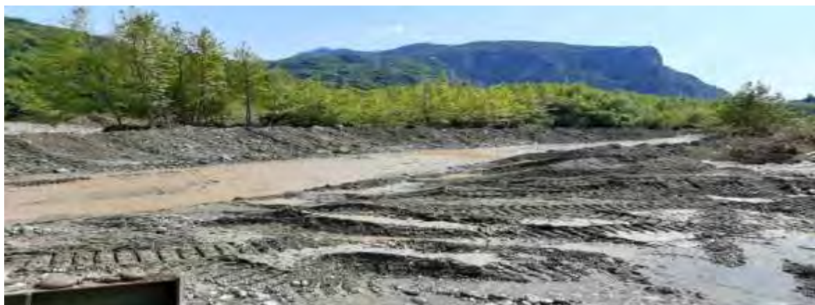
Εικόνα 82 : Διευθέτηση του Ρέματος Παμισσού στο Μουζάκι Τρικάλων μετά από μεταφορά φερτών υλικών , κατά τον Μεσογειακό κυκλώνα IANOS. (Θεσσαλία)(Πηγή: Προσωπικό Αρχείο)
