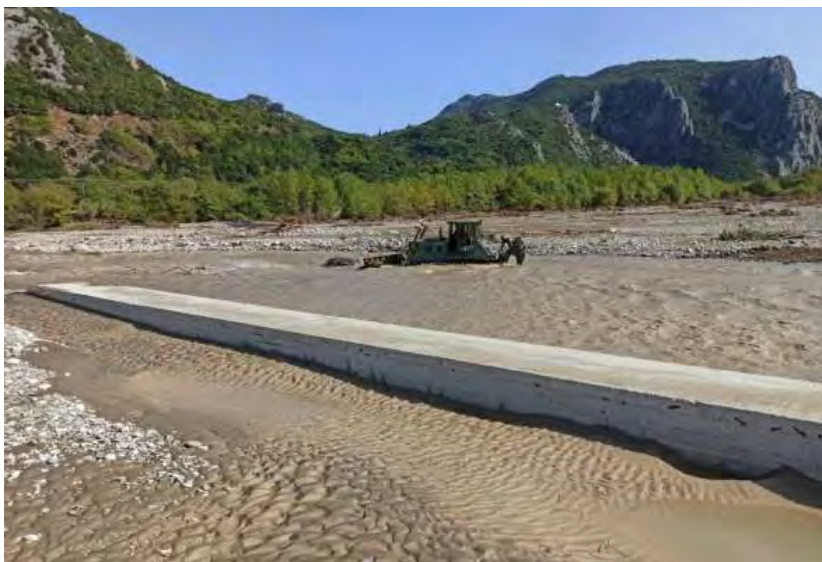
Εικόνα 77 : Διευθέτηση για άρση των εμποδίων και αποκατάσταση της ροής του π. Παμισσού στο Μουζάκι Τρικάλων μετά από μεταφορά φερτών υλικών , κατά τον Μεσογειακό κυκλώνα ΙΑΝΟΣ. (Θεσσαλία) (Πηγή: Προσωπικό Αρχείο)
