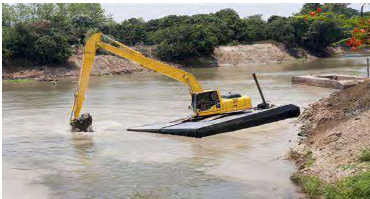
Εικόνα 76 : Βυθοκόρηση ποταμού με την χρήση Εκσκαφέα Τάφρων εντός Πλωτήρα για την επαύξηση της ικανότητας καθαρισμού σε μεγαλύτερο πλάτος και βάθος ποταμού (Πηγή: Διαδίκτυο)
