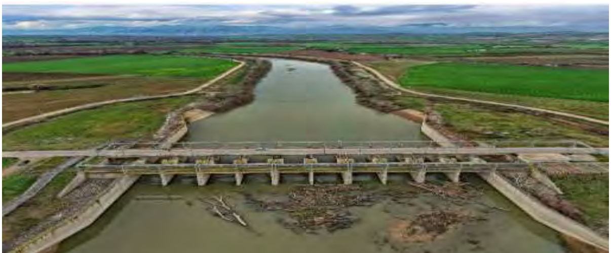
Εικόνα 95: Το φράγμα ή ρουφράκτης Πηνειού ποταμού στη Γυρτώνη της ΠΕ Λάρισας κατά την τεχνική ορολογία έχει ως σκοπό την συλλογή ταμίευση και εξασφάλισης συγκεκριμένης πλήρωσης αγωγού(+63 μ) στον . Με τον τρόπο αυτό πετυχαίνεται η άρδευση των γύρω γεωργικών οικοσυστημάτων όπως και παροχής νερού σε λιμνοδεξαμενές του ΤΟΕΒ Πηνειού και της λίμνης Κάρλας χωρίς την χρήση ηλεκτρικών αντλιοστασίων. (Πηγή: Διαδίκτυο)
