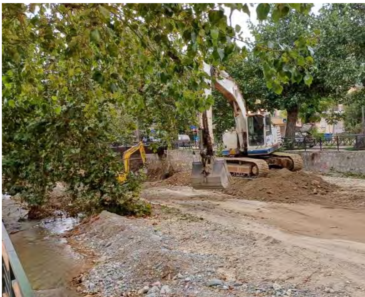
Εικόνα 78 : Εργασίες διευθέτησης υδατορέματος Κραυσίδανα στο Βόλο από τις πλημμύρες που προκάλεσε η καταιγίδα NTANIEA τον Σεπ 2023. Εργασίες που καθυστέρησε η εναρξή τους (15-20 ημέρες) μετά την έλευση της πλημμύρας με αποτέλεσμα το κορεσμένο υδατόρεμα να έχει μικρή δυνατότητα παροχετευτικότητας. (Πηγή:Προσωπικό Αρχείο)
