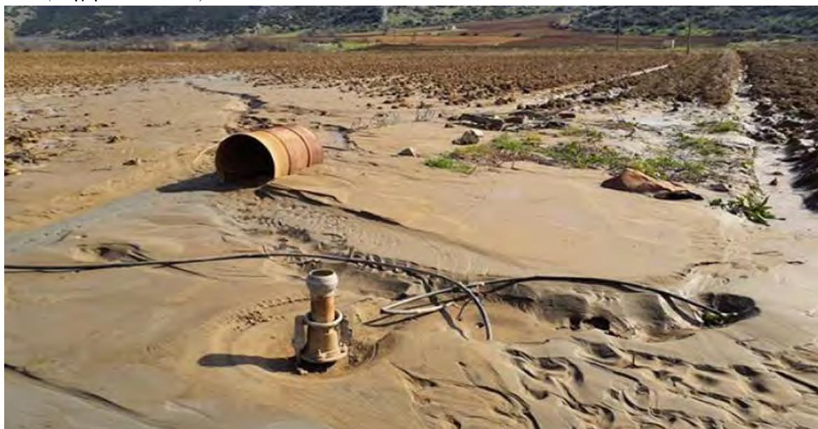
Εικόνα 40: Εμφάνιση Ρευστοποίησης στην Πηνειάδα Θεσσαλίας μετά από τον Σεισμό Τυρνάβου 6 Μαρ 22. (Πηγή: https://eleftherostypos.gr/ )
