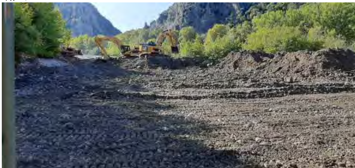
Εικόνα 86 : Διευθέτηση για αύξηση της παροχευτικότητας του π. Παμισσού στο Μουζάκι Τρικάλων μετά από μεταφορά φερτών υλικών , κατά τον Μεσογειακό κυκλώνα ΙΑΝΟΣ. (Θεσσαλία) (Πηγή: Προσωπικό Αρχείο)
