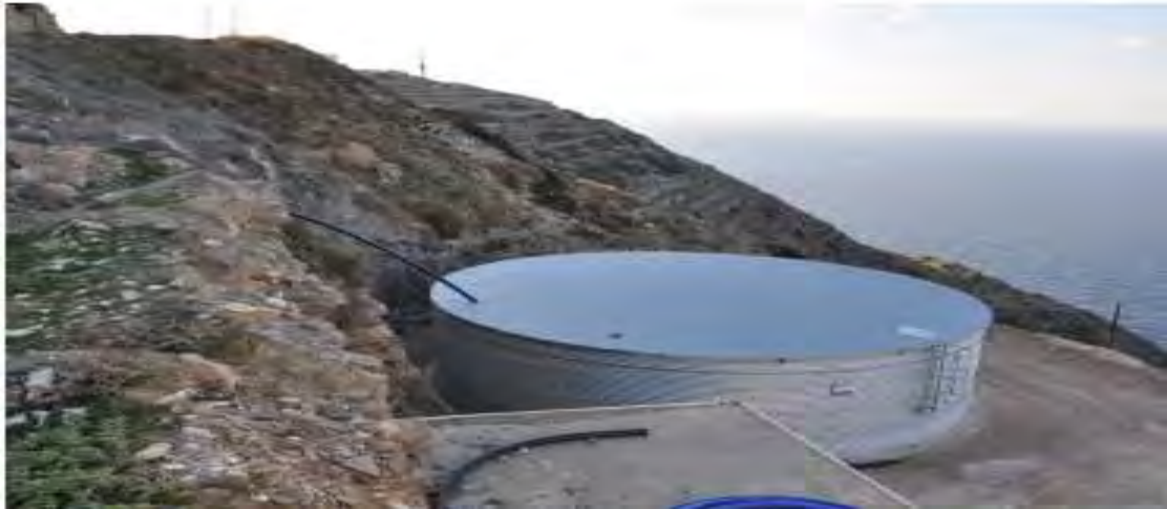
Εικόνα 55 : Μεταλλοδεξαμενές αποταμίευσης όμβριων υδάτων σε νησιά των Κυκλάδων, Ελλάς. (πηγή: Global World Ppartnership -Med)
