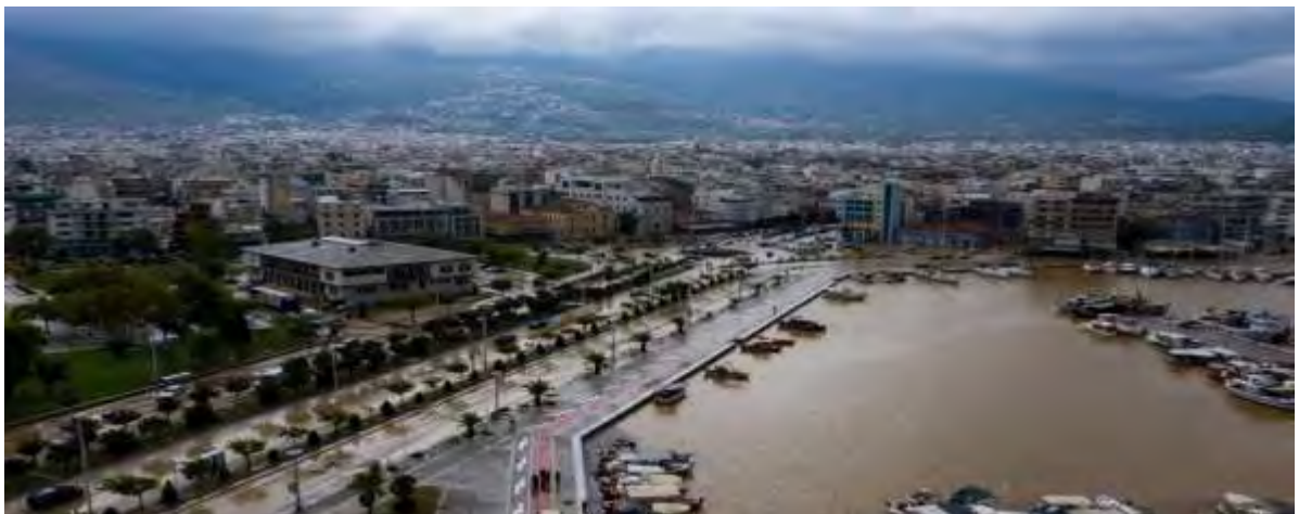
Εικόνα 115: Η Θαλάσσια περιοχή του Λιμανιού του Βόλου πλημμυρισμένο από το ρέμα του Κραυσίδωνα, από τις παρόδιες περιοχές και από τους αγωγούς ομβρίων υδάτων από την Καταιγίδα NTANIEL. (Πηγή: magnesiassnews.gr )
