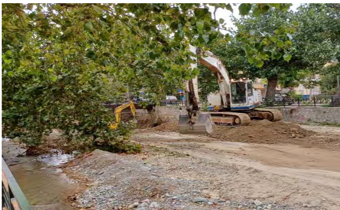
Εικόνα 17 : Εργασίες διευθέτησης υδατορέματος Κρανσίδωνα στο Βόλο από τις πλημμύρες που προκάλεσε η καταιγίδα NTANIEA τον Σεπ 2023. Μετά την έλευση της πλημμύρας με αποτέλεσμα το κορεσμένο υδατόρεμα να έχει μικρή δυνατότητα παροχευτικότητας. (Πηγή: Προσωπικό Αρχείο)
