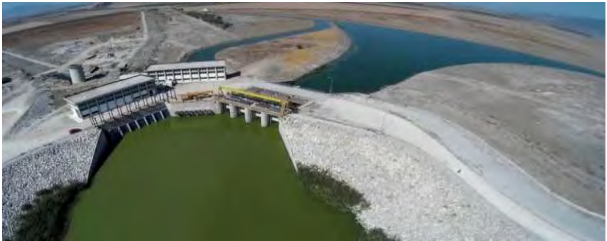
Εικόνα 94: Φράγμα και αποστραγγιστικό έργο της Λίμνης Κάρλας . Επιπλέον διακρίνεται και το έργο οδικής επικοινωνίας και ελέγχου (Πηγή: Διαδίκτυο)
