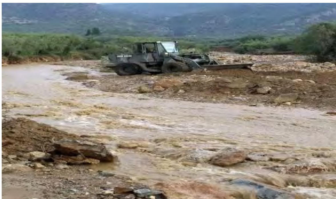
Εικόνα 73: Εργασίες Αποκατάστασης στα ανάντη του πλημμυρισμένου χείμαρρου από την καταιγίδα Ελίας στην Αγριά Βόλου (Πηγή: Προσωπικό Αρχείο)..
