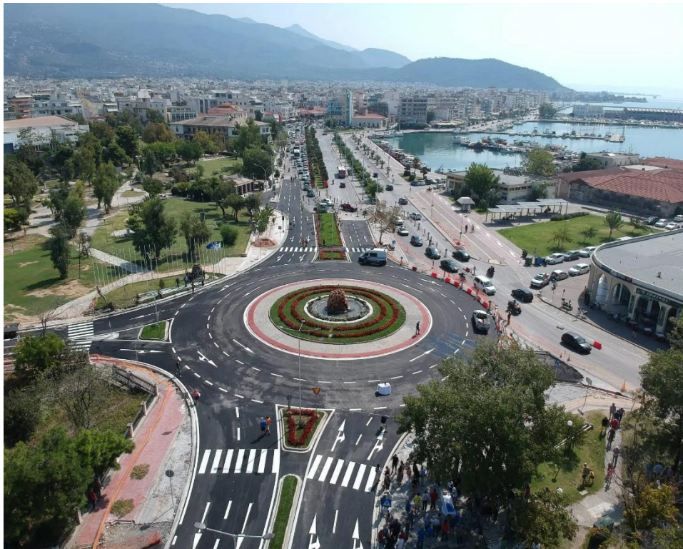
Εικόνα 1.2: Κυκλικός κόμβος Τελωνίου( e-thessalia )
