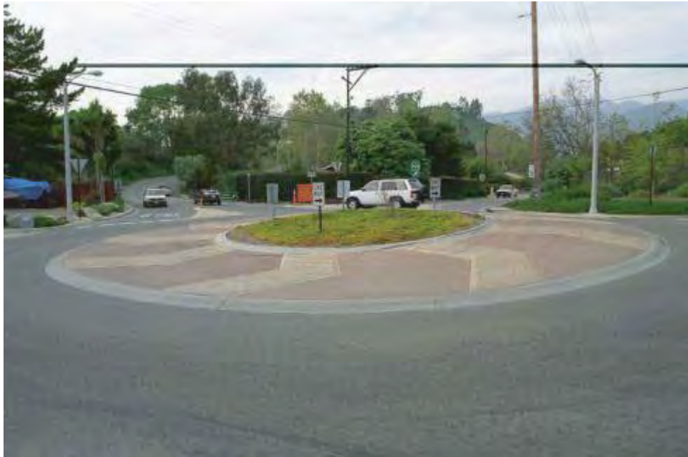
Εικόνα 2.9 : Προσπελάσιμη περιμετρική ζώνη της κυκλικής κεντρικής νησίδας για βαρέα οχήματα
