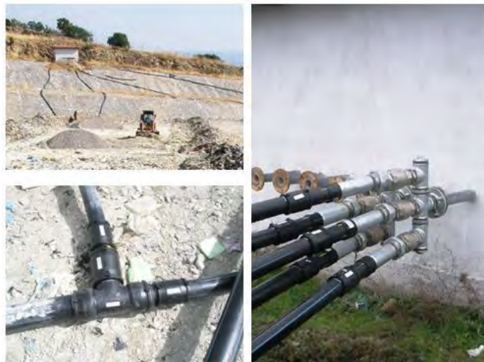
Εικόνα 29 Δευτερεύον δίκτυο μεταφοράς σύνδεση με οριζόντιο.
