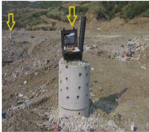
Εικόνα 25 Κατασκευή κατακόρυφου δικτύου.
