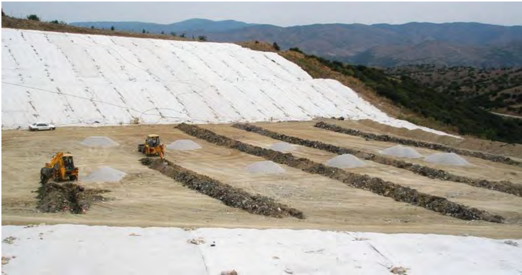
Εικόνα 21 . Κατασκευή οριζόντιου δικτύου 20
