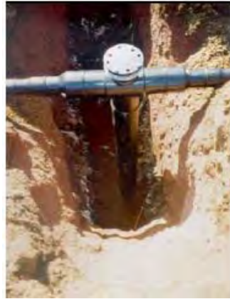
Εικόνα 30 Διαχωριστής συμπυκνωμάτων 24
