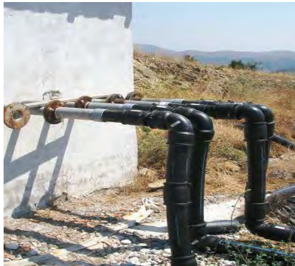
Εικόνα 27 Σύνδεση δευτερεύοντος δικτύου μεταφοράς .
