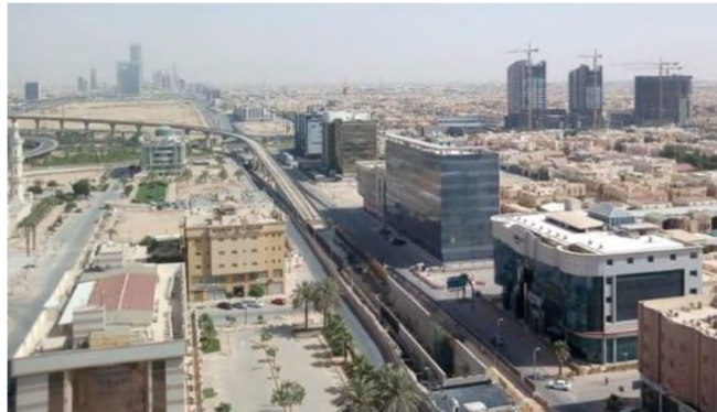
Εικόνα 10: Υπό κατασκευή σταθμός υπέργειου δικτύου μετρό στο κεντρικό Ριάντ.
