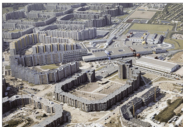
Σχήμα 9. Αμβούργο, Steilshoop 2009. Άποψη του συγκροτήματος από τα ανατολικά
