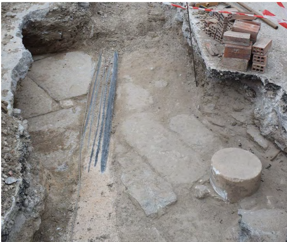
Εικ. 17, Εργασίες ΔΕΥΑΠ, 2021, Τμήμα πλακόστρωτης οδού στη θέση «Καστροβούνι» Η «εγκάρσια οδός 2-Ε2)
