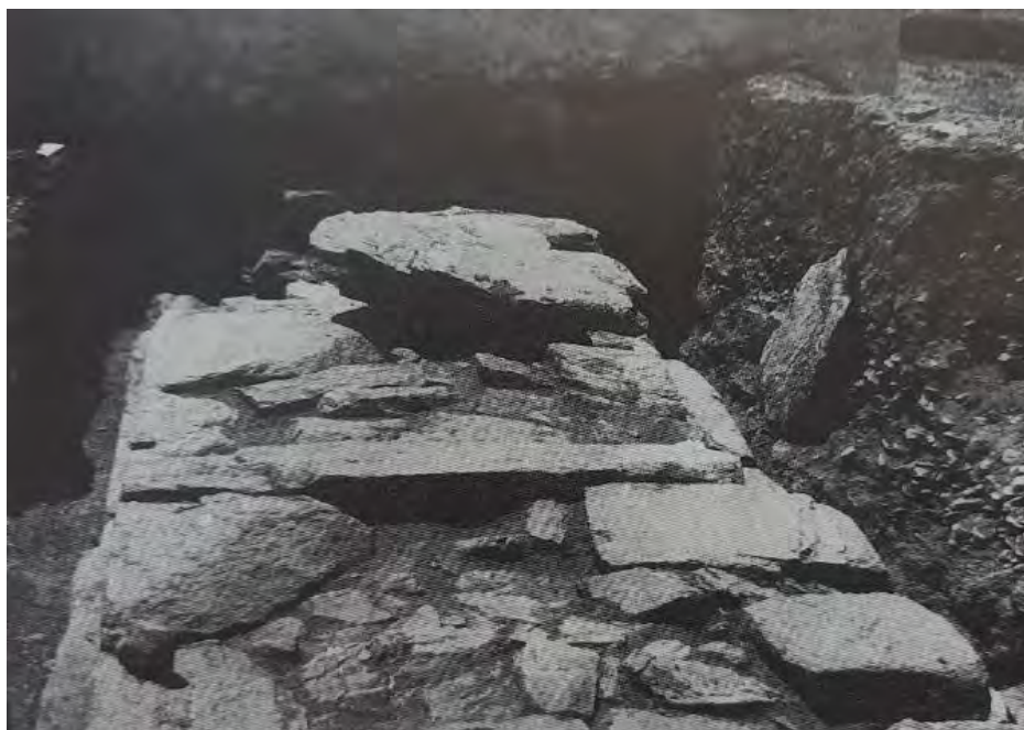
Εικ.12, Οικόπεδο Κ. Μπαρμπαρή, Τμήμα του αρχαίου τείχους της πόλεως.(Ζαφειροπούλου 1987, ΑΔ Β2, πιν. 293α)
