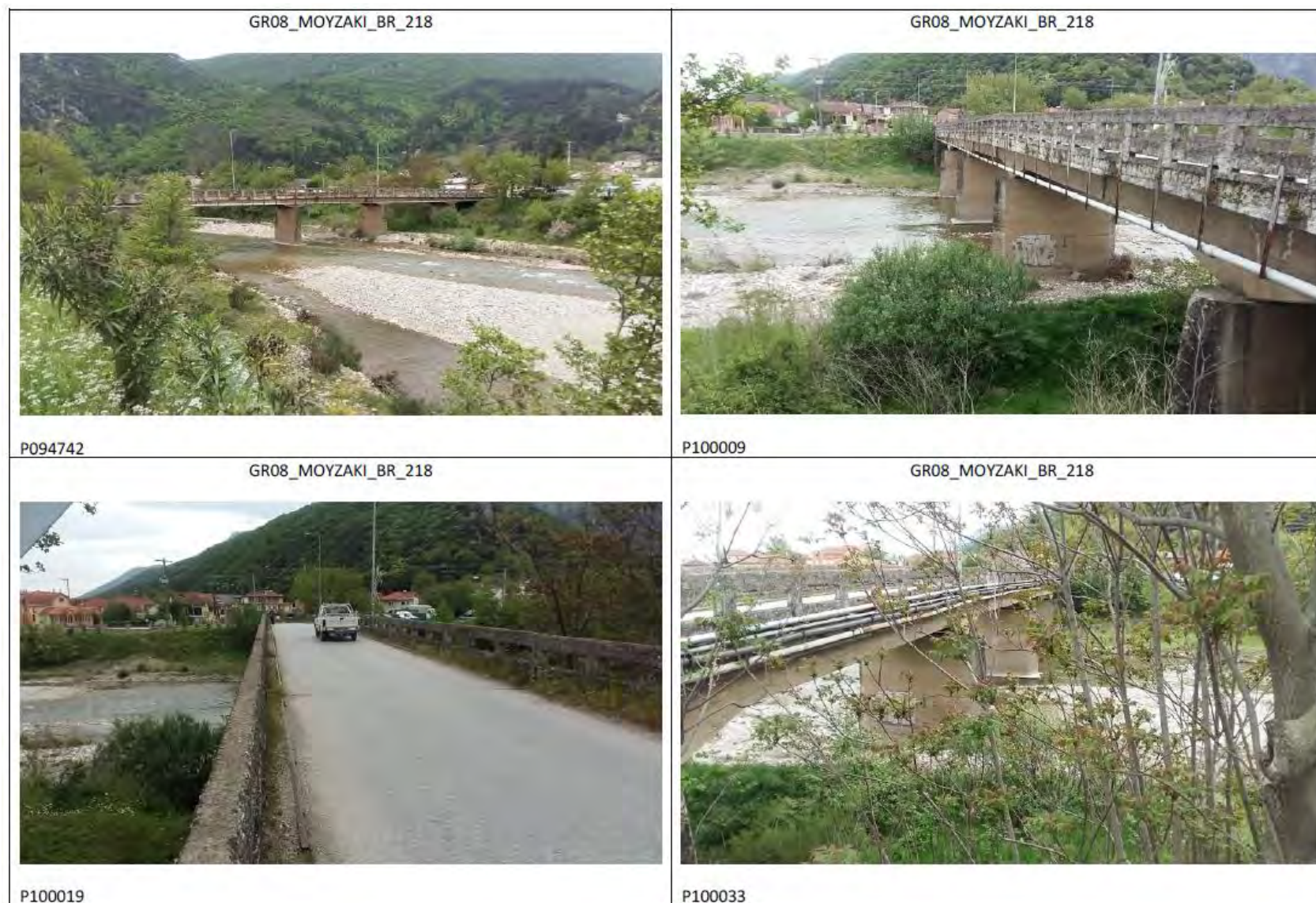
Σχήμα 3.5 Φωτογραφικές απόψεις της γέφυρας BR-218, στο χωριό Μουζάκι ( Χρήστος Σαλογιάννος).
