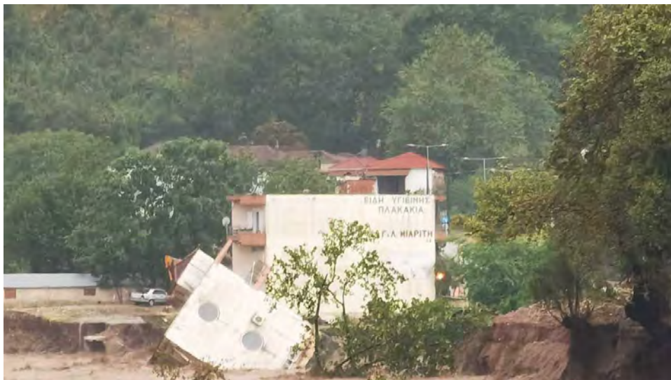
Σχήμα 2.25 Διαβρώσεις στην βόρεια όχθη του ποταμού Πάμισου και άποψη γυμναστηρίου που κατέρρευσε, Μουζάκι Καρδίτσας μετά το πέρασμα της κακοκαιρίας “Daniel”.
