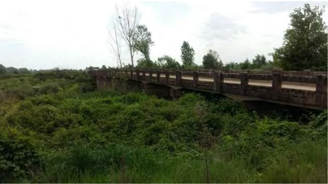
Σχήμα 3.30 Άποψη της κοίτης του ποταμού ανάντη της γέφυρας BR 212.
