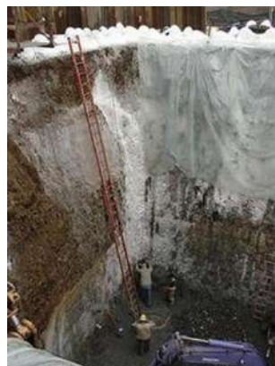
Εικόνα 23: Εφαρμογή μεθόδου ψύξης του εδάφους σε βαθιά εκσκαφή
