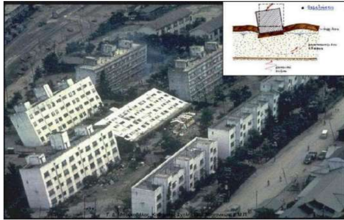
Εικόνα 6: Αστοχία λόγω ρευστοποίησης εδάφους - Niigata, Ιαπωνία (1964)
