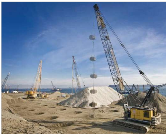
Εικόνα 19: Εφαρμογή της μεθόδου δυναμικής συμπίκνωσης
