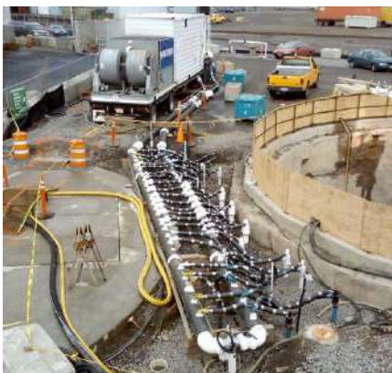
Εικόνα 22: Διάταξη ψύξης του εδάφους για σταθεροποίηση
