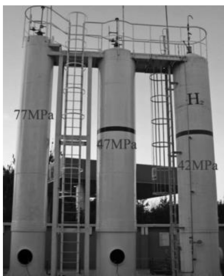
Σχήμα 6.3. Δεξαμενές αποθήκευσης υδρογόνου σε διαφορετικές πιέσεις [197].
