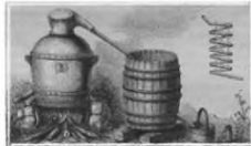
Άμβυκας απόσταξης στέμφυλων τύπου με βραχίονα
