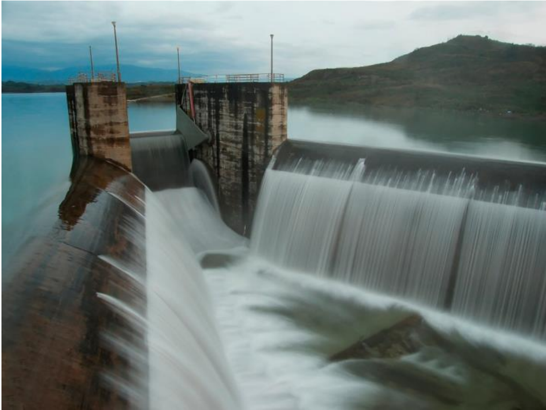
Εικόνα 2.5 Υπερχειλιστής φράγματος Πηνειού [16].
