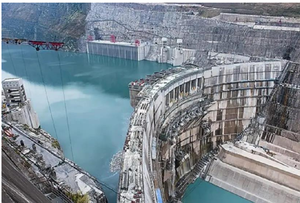
Εικόνα 1.7 Σταθμός υδροηλεκτρικής ενέργειας Xiluodu ( Τα υπερηλεκτρικά εργοστάσια στον κόσμο | Πράσινες ανανεώσιμες πηγές (renovablesverdes.com) ).
