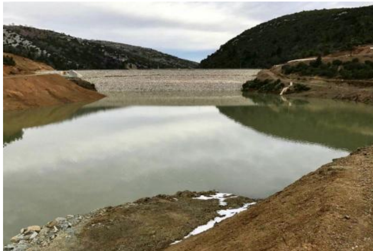
Εικόνα 2.4 Χωμάτινο φράγμα Μαυροματίου Σούρπης Μαγνησίας [15]
