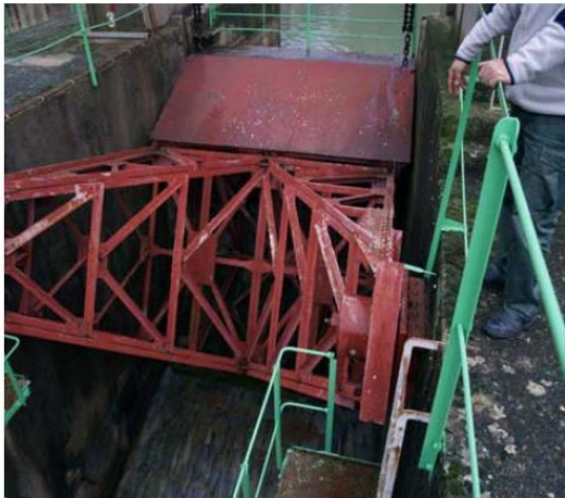
Εικόνα 2.7 Ηλεκτρικό τοξωτό θυρόφραγμα και αυτόματο θυρόφραγμα με αντίβαρο ΥΗΣ Γλαύκου [17].
