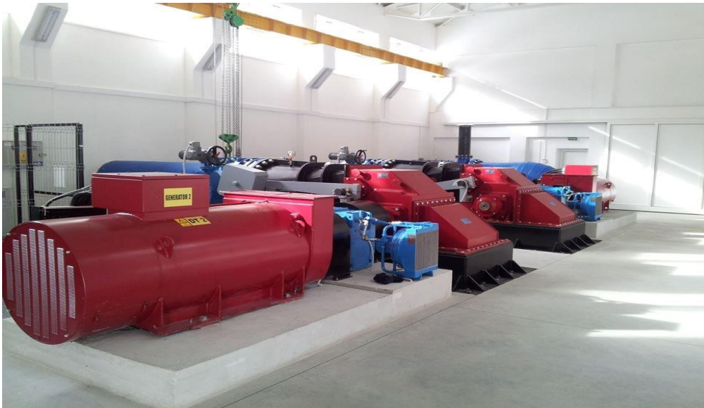
Εικόνα 3.2 και 3.3 Cross-flow Στρόβιλοι ( Crossflow turbines | CINK Hydro - Energy k.s. (cink-hydro-energy.com) ).
