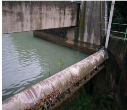
Εικόνα 2.7 Ηλεκτρικό τοξωτό θυρόφραγμα και αυτόματο θυρόφραγμα με αντίβαρο ΥΗΣ Γλαύκου [17].
