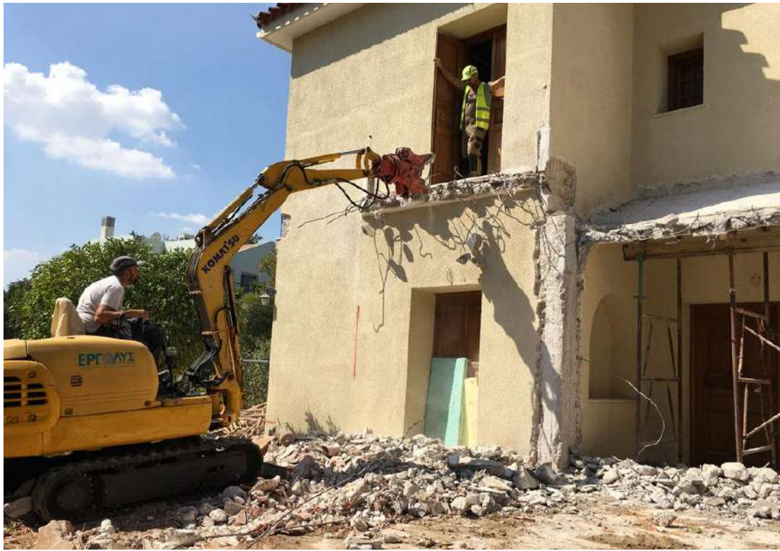
Εικόνα 17: Σύνθλιψη σκυροδέματος (egolys.gr)
