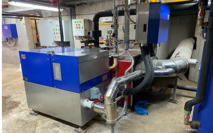
Εικόνα 3.1 Σύστημα συμπαραγωγής στη βιομηχανία
