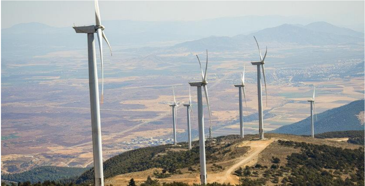
Εικόνα 7.9: Αιολικό πάρκο στη Βοσνία και Ερζεγοβίνη [60]
