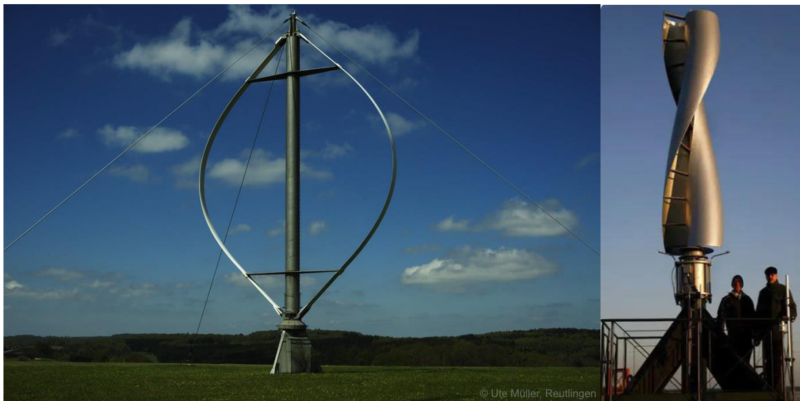
Εικόνα 7.6: Ανεμογεννήτριες κατακόρυφου άξονα Darrieus αριστερά [54] και Savonius δεξιά [55]
