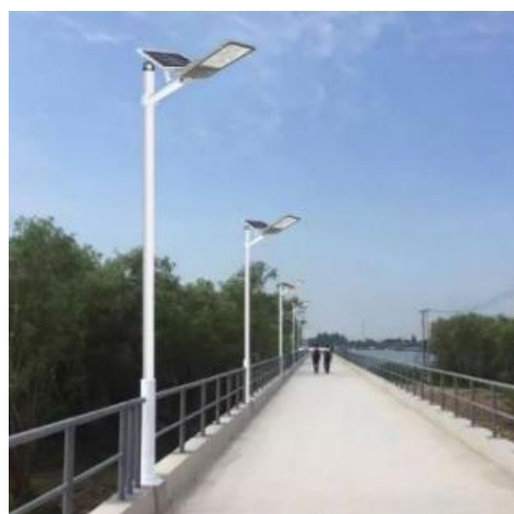
Εικόνα 79: στήλη φωτισμού με ενσωματωμένα φωτοβολταϊκά Πηγή: https://787.gr/tekhnologia-and-energeia/fotismos/iliaka-fotistika/
