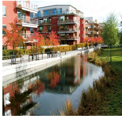
Εικόνα 16: Παρακολούθηση κατανάλωσης ενέργειας και νερού
