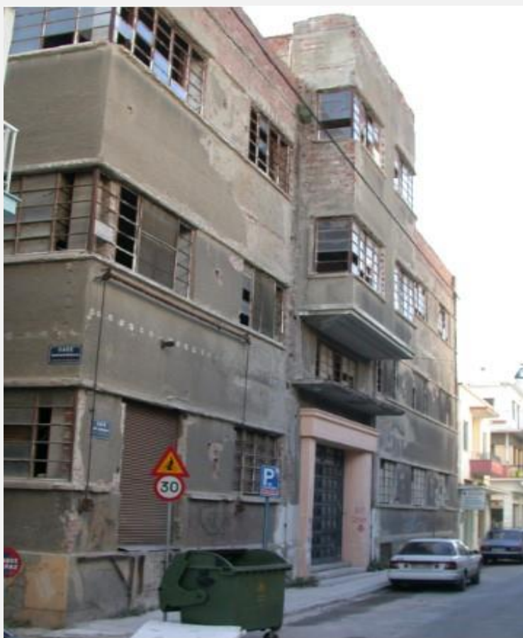
Εικόνα 5: Κτήριο Ματσάγγου, σήμερα
