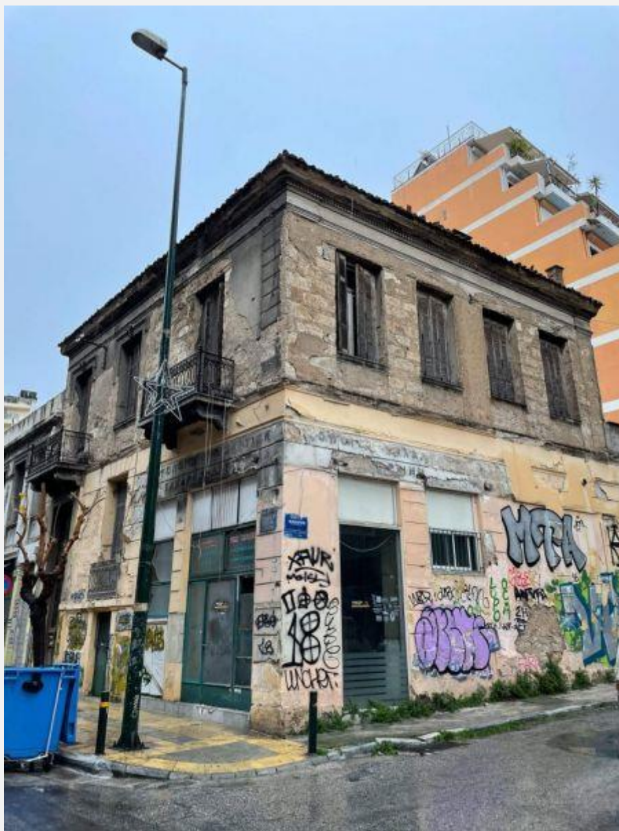
Εικόνα 11: Παραδείγματα εγκαταλελειμμένων κτηρίων στο κέντρο της Αθήνας 2/3
