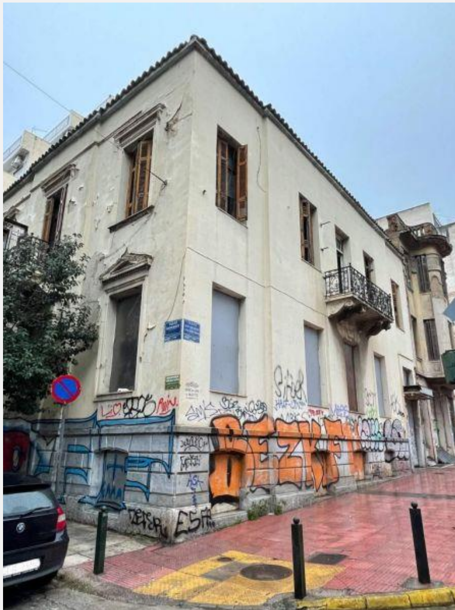
Εικόνα 12: Παραδείγματα εγκαταλελειμμένων κτηρίων στο κέντρο της Αθήνας 3/3
