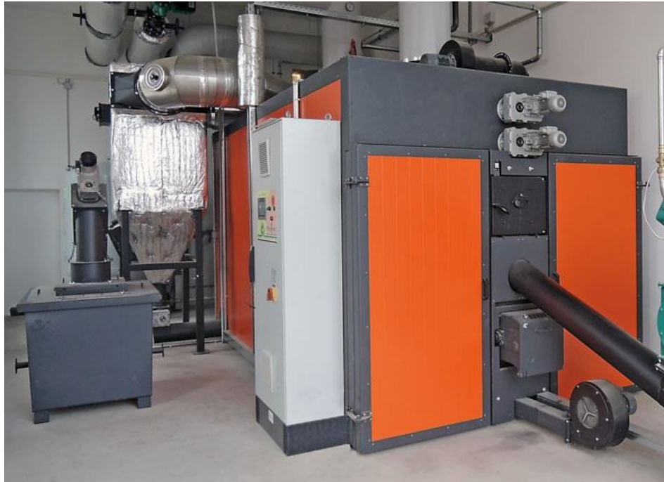
Εικόνα 12: Τυπικός καυστήρας βιομάζας για βιομηχανίες.
