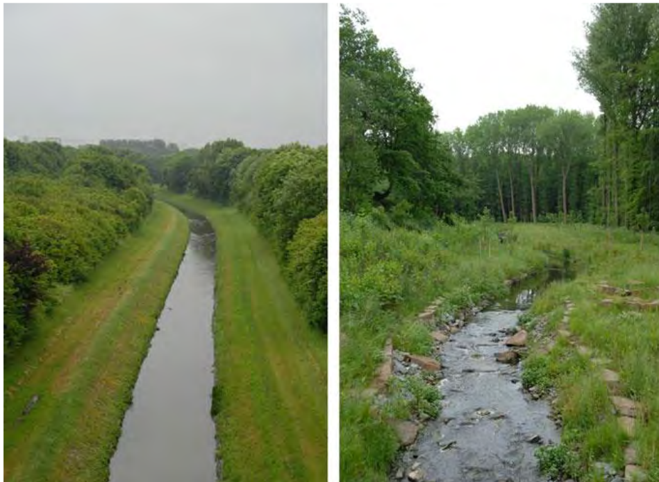
Εικόνες 15 & 16: Σύγκριση τμημάτων του ποταμού Emscher: Δεξιά άποψη της ανάπλασης του ποταμού Πηγή: Sustainable Landscape Planning in Selected Urban Regions, p.220
