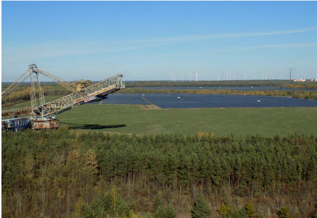
Εικόνα 24: Φωτοβολταϊκά πάρκα στο πρώην ορυχείο Meuro
