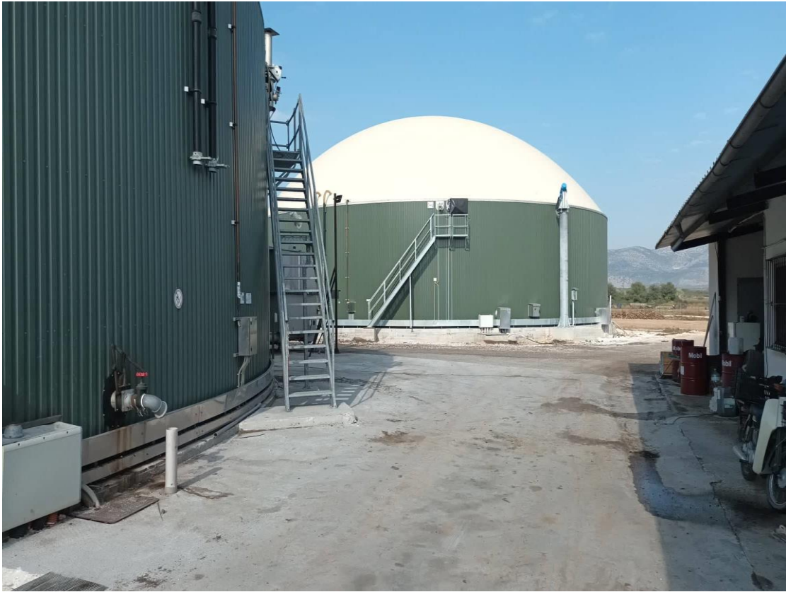
Εικόνα 16 σκάλα προς το σημείο ελέγχου οροφής
