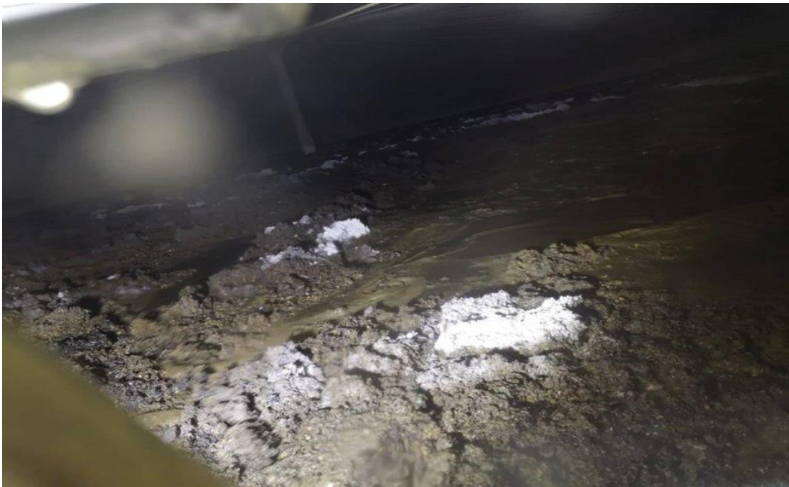
Εικόνα 17 Εικόνα από το σημείο ελέγχου(Το λευκό χρώμα είναι επίστρωμα θείου)
