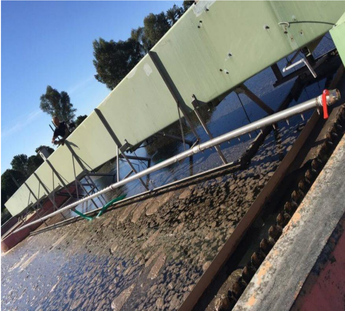
Εικόνα 19 Η δεξαμενή καθίζησης
