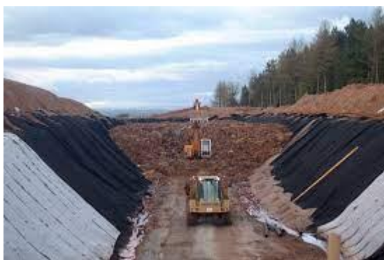
Σχήμα 3.2 Τοποθέτηση γεωϋφασμάτων (Στρογγύλης, 2016)
