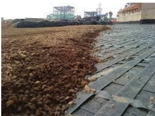
Σχήμα 3.4 Οπλισμένο έδαφος με μεταλλικές λωρίδες
