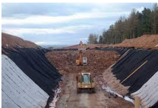
Σχήμα 3.2 Τοποθέτηση γεωϋφασμάτων (Στρογγύλης, 2016)
