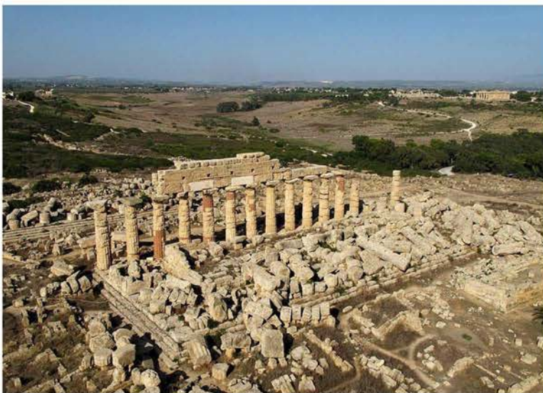
Εικόνα 98. Ναός C (ακρόπολη Σελινούντα). Πάνω διακρίνεται το πεσμένο βόρειο περιστύλιο, που στη συνέχεια ανοικοδομήθηκε. Κάτω διακρίνεται και η πτώση του νότιου περιστυλίου που έμεινε in situ (πηγές: Guidoboni et al. 2002, 2967, fig.4 και https://en.visitselinunte.com/archaeological-park/temples/2-temple-c.htm )
