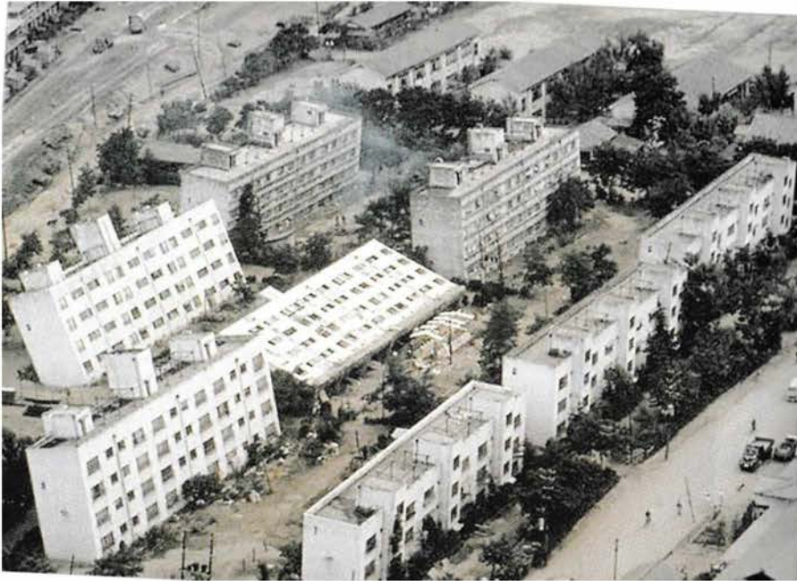
Εικόνα 8. Αποτελέσματα της ρευστοποίησης των εδαφών στα κτίρια (κλίση 75 μοιρών σε ένα από αυτά) (Ιαπωνία, 1964) (πηγή: Παπαζάχος κ.ά. 2005, 292, σχ. 8.6)
