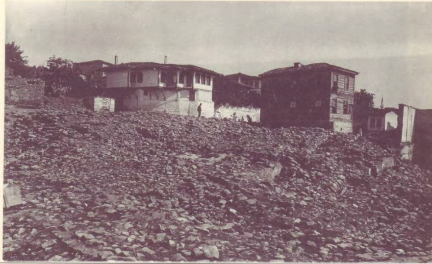
εικ. 6 : κατά τη διάρκεια κατασκευής της πλατείας
