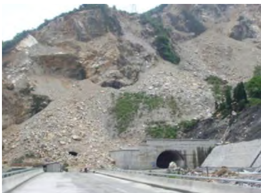
Εικόνα 2.1: Κατολίσθηση στην είσοδο της σήραγγας Longdongzi μετά το σεισμό Wenchuan (Li, 2011)
