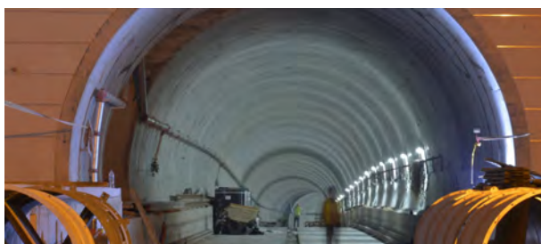
Εικόνα 3.2: Διατομή υπό κατασκευής σήραγγας του μετρό της Αθήνας (“ΑΤΤΙΚΟ ΜΕΤΡΟ Α.Ε.”, 2021)
