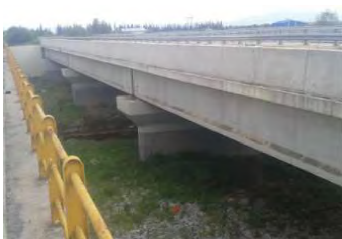
Σχήμα 27 Πλευρική φωτογραφία γέφυρας
