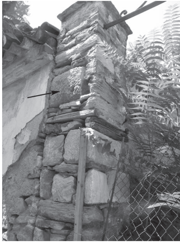
Εικ. 7. Άποψη από σύγχρονη χρήση τραβερτινικού υλικού σε λιθόκτιστη οικία του 20ου αι.
