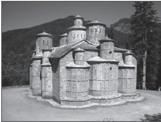
Εικ. 1. Γενική άποψη του Ιερού Ναού Τιμίου Σταυρού Δολιανών Κρανιάς.
