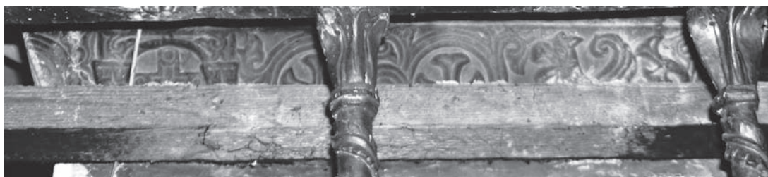
Εικ. 14. Επιστύλιο από μεσοβυζαντινό τέμπλο εντοιχισμένο ως κοσμήτης στο δυτικό μέτωπο του βόρειο πεσσότοιχου του Ιερού του ναού.
