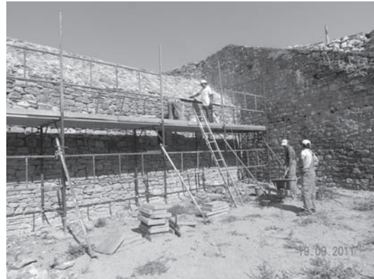
Εικ. 2. Τρίκαλα. Βυζαντινό κάστρο. Εργασίες αποκατάστασης τρίτου διαζώματος (έργο ΕΣΠΑ).
