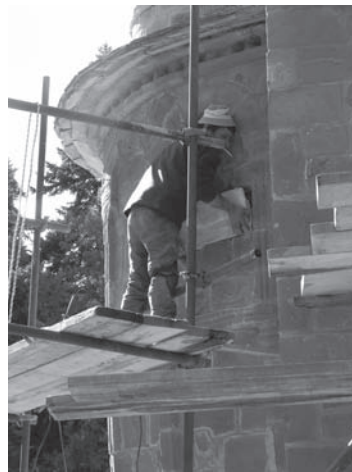
Εικ. 4. Κρανιά Ασπροποτάμου. Ι.Ν. Τιμίου Σταυρού. Εργασίες αντικατάστασης λίθων και λιθαναγλύφων (έργο ΕΣΠΑ).
