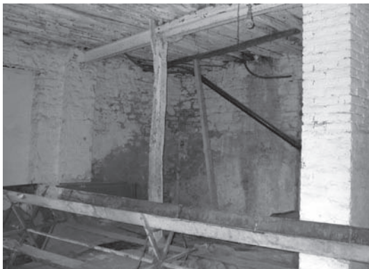
Εικ. 7. Άποψη του ισογείου. Υπάρχουσα κατάσταση.
