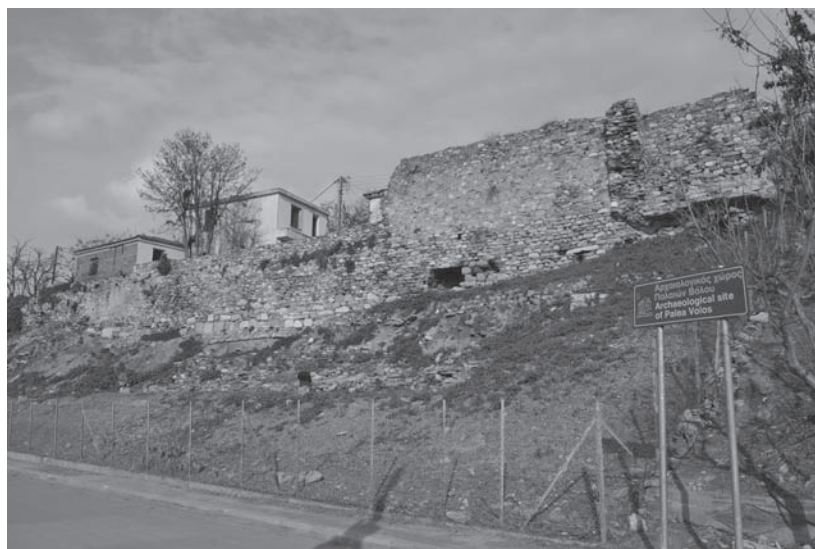
Εικ. 2. Κάστρο Βόλου. Νοτιοδυτική πλευρά.
