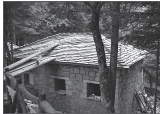
Εικ. 6. Κτίριο χώρων υγιεινής.
