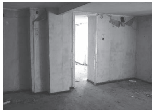
Εικ. 8. Άποψη του ορόφου. Υπάρχουσα κατάσταση.
