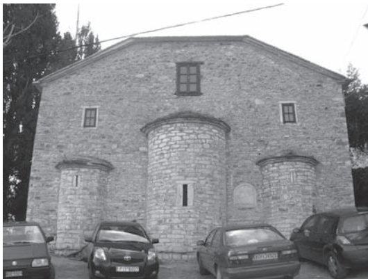
Εικ. 2. Μακρινίτσα, Άγιος Αθανάσιος. Ανατολική πλευρά, μετά την αποκατάσταση (2012).
