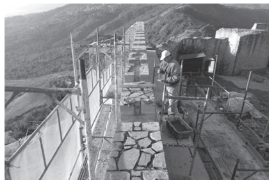
Εικ. 6. Φανάρι Καρδίτσας. Βυζαντινό κάστρο. Εργασίες αποκατάστασης τμημάτων του τείχους (έργο ΕΣΠΑ).
