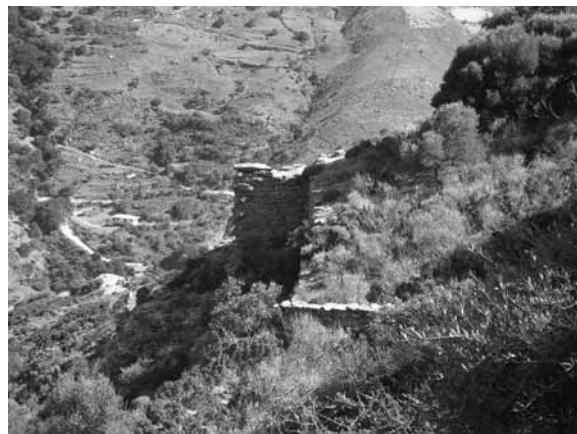
Εικ. 4. Φιλάγρα Μαρμαρίου. Πύργος της οχύρωσης.
