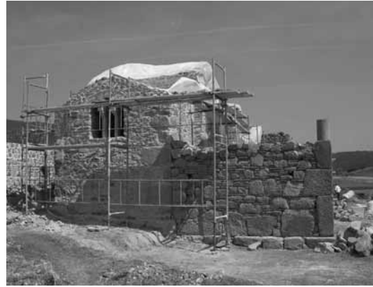
Εικ. 8. Επίβλεψη εργασιών αποκατάστασης Αγίου Γεωργίου Σφάκας (13ος-16ος αι.).
