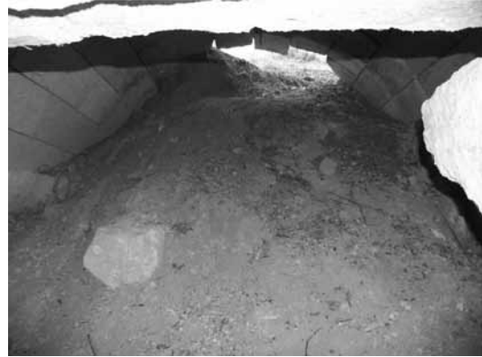
Εικ. 2. Εσωτερικό του θαλάμου πριν την αφαίρεση των χωμάτων.
