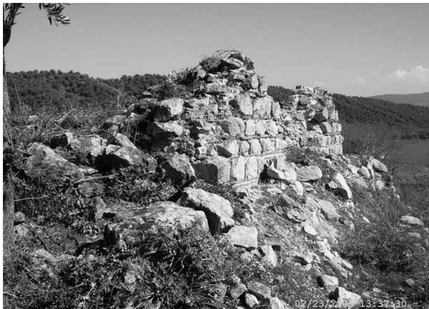
Εικ. 7. Φραγκκλησιά. Νότιος τοίχος του μεσοβυζαντινού κτίσματος, μετά από τον καθαρισμό.
