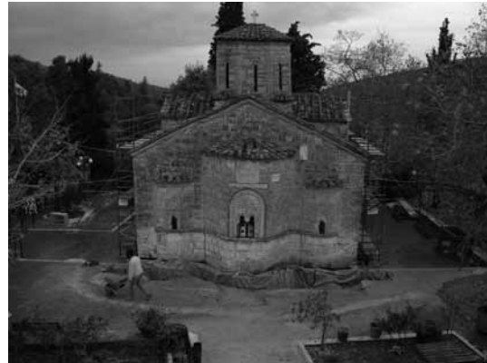
Εικ. 6. Εργασίες για την κατασκευή αποστραγγιστικής τάφρου.
