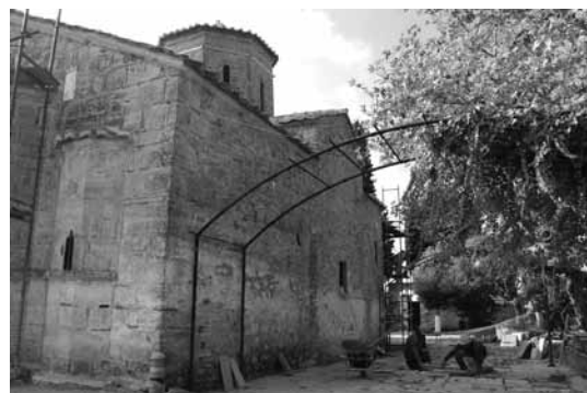
Εικ. 10. Διαμόρφωση περιβάλλοντος χώρου. Επίστρωση με λιθόπλακες στο βόρειο αύλειο χώρο του ναού.
