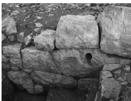
Εικ. 9. Αρβάλα Ναυπάκτου, τομή στο εσωτερικό του περιβόλου.
