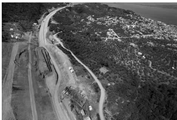
Εικ. 1. Το Ασκληπιείο στην αρχική του θέση κατά τη διάρκεια των εργασιών κατασκευής του αυτοκινητόδρομου ΠΑΘΕ στο ύψος της παράκαμψης του Αγίου Κωνσταντίνου.
