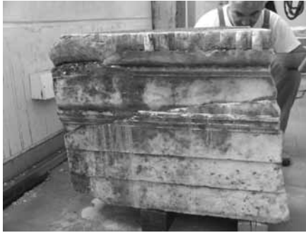
Εικ. 7. Συγκόλληση τμημάτων του θριγκού δικιόνιου μνημείου.
