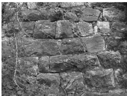
Εικ. 4. Ακανόνιστο τραπεζιόσχημο σύστημα δόμησης στην περιοχή του δυτικού μεσαιωνικού τείχους.
