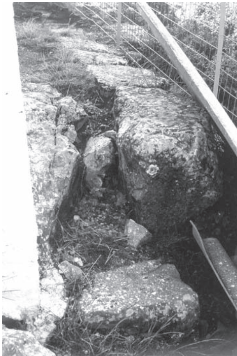
Fig. 7. Il lato nord dell'edificio di Haghia Marina.
