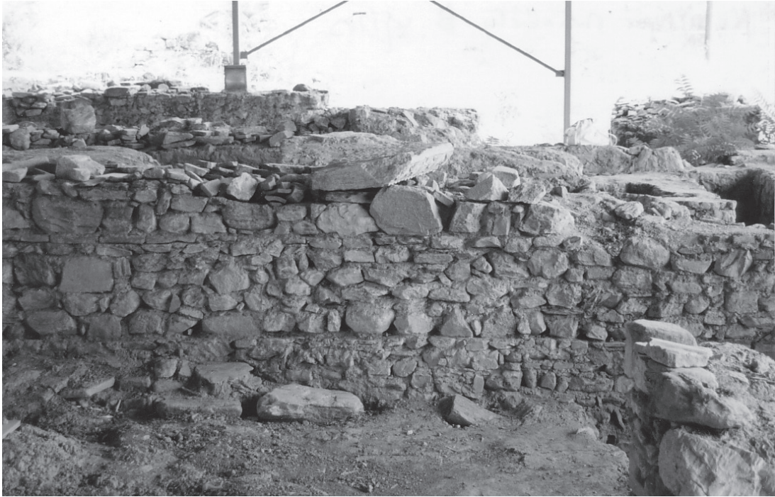
Εικ. 5. Τοιχοδομία θεμελίου βόρειου στυλοβάτη.
