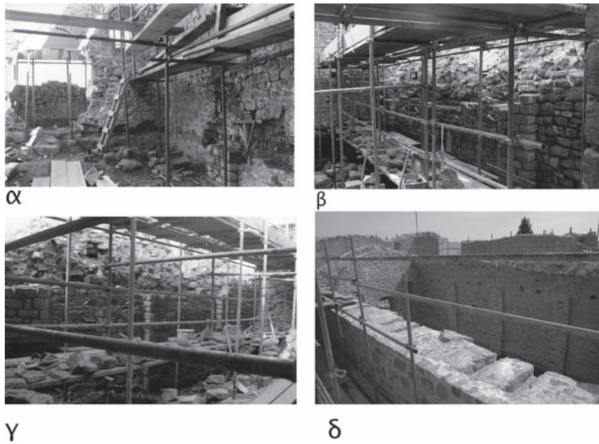
Εικ. 4. α. Πυριτιδαποθήκη-Εσωτερική ΒΑ άποψη (κατά τις εργασίες), β. Πυριτιδαποθήκη-Εσωτερική ΝΔ άποψη (κατά τις εργασίες), γ. Πυριτιδαποθήκη- Εσωτερική ΒΔ άποψη (κατά τις εργασίες), δ. Πυριτιδαποθήκη- ΒΑ άποψη από ψηλά (μετά τις εργασίες).
