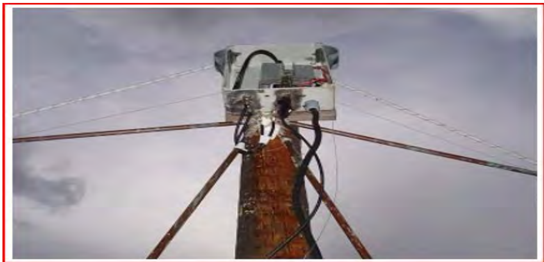
Εικόνα 1.10.α) Άποψη της ανεστραμμένης V διπολικής κεραίας , από το Βορρά. β) Εδώ εμφανίζεται το κουτί στη κορυφή της κεραίας και τα δυο βασικά καλώδια τροφοδοσίας (χοντρό και σήματος (λεπτό)).[2].
