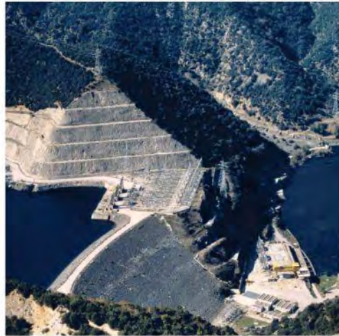
Σχήμα 4.5: Άποψη από το Αναστρέψιμο Υδροηλεκτρικό Έργο Σφηκιάς [49]
