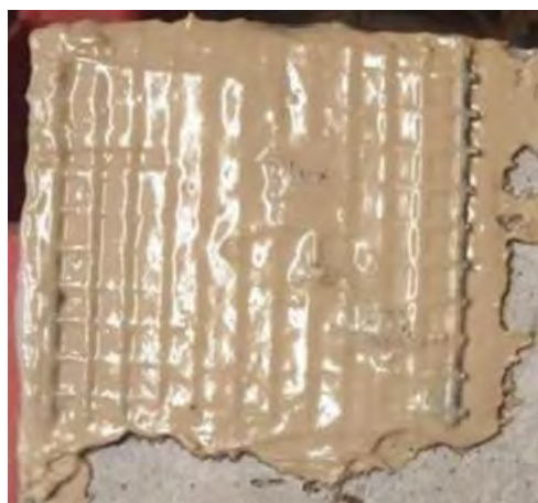
Σχήμα 11. Εφαρμογή κονιάματος σε επιφάνεια σκυροδέματος με ινόπλεγμα
