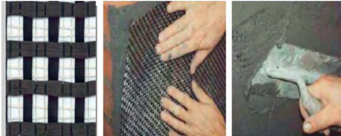
Σχήμα 2. Ινοπλέγμα σε Ανόργανη Μήτρα (IAM). (D'Ambrisi et al., 2013)
