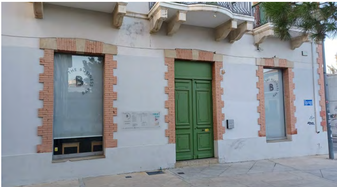
Εικόνα 50. Δημιουργία χώρων γραφείων σε διατηρητέο κτίσμα μπροστά στην πλατεία Πανεπιστημίου. Πηγή: προσωπικό αρχείο. Ημ/νια λήψης: 17/12/21.
