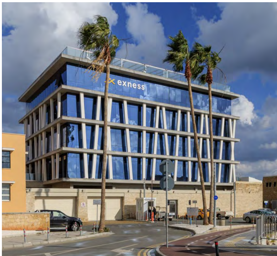
Εικόνα 34. Γραφειακοί χώροι Ιδιωτικών εταιρειών πλησίον Νέας Μαρίνας Λεμεσού.
