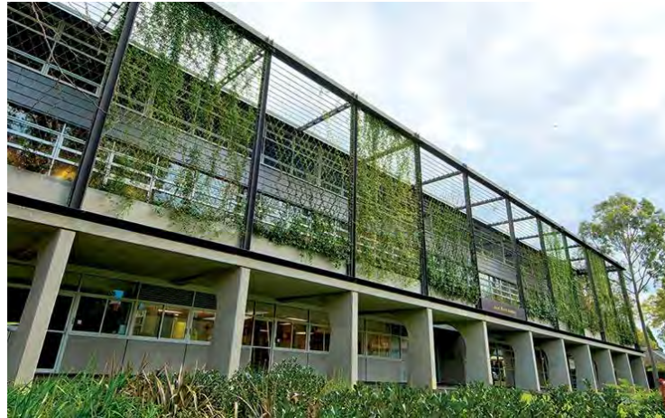
Εικόνα 88. Εφαρμογής κάθετης φύτευσης σε πρόσοψη κτιρίου με την χρήση μεταλλικού πλέγματος, Πηγή: RONSTAN, 2022.
