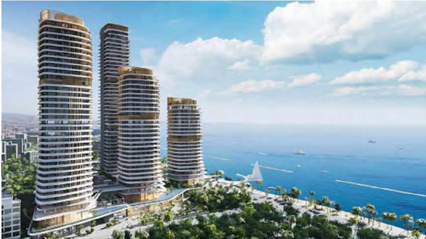
Εικόνα 35. Έργο NEO (αριθμός 1 στον χάρτη 12): ψηλό κτίριο με χρήση κατοικιών –Πηγή: in-Cyprus, 2019.
